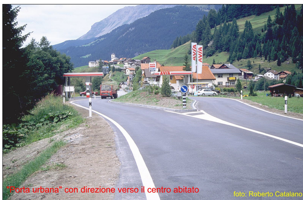
Fig. 2 – Porta urbana realizzata con aiuola centrale a creare una deviazione d'asse
