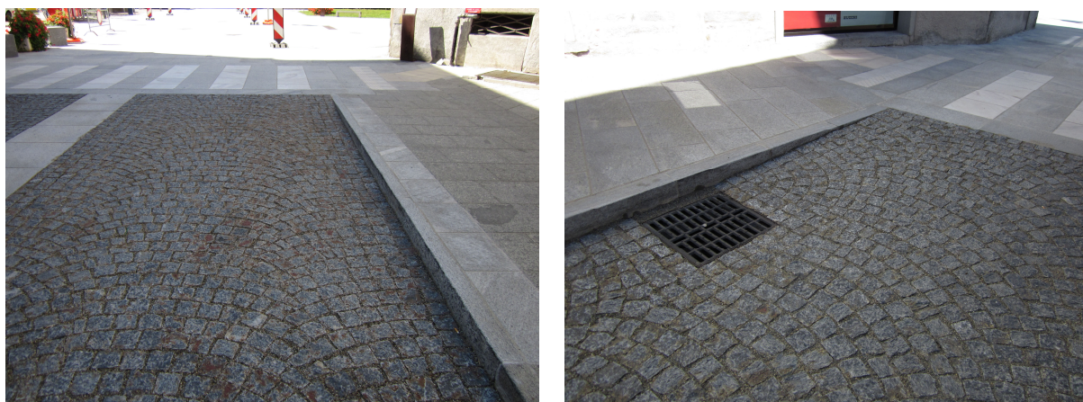
Figg. 19 a e 19 b – Esempio di attraversamento pedonale su piattaforma rialzata e posizionamento della griglia di raccolta delle acque meteoriche a monte del dispositivo
